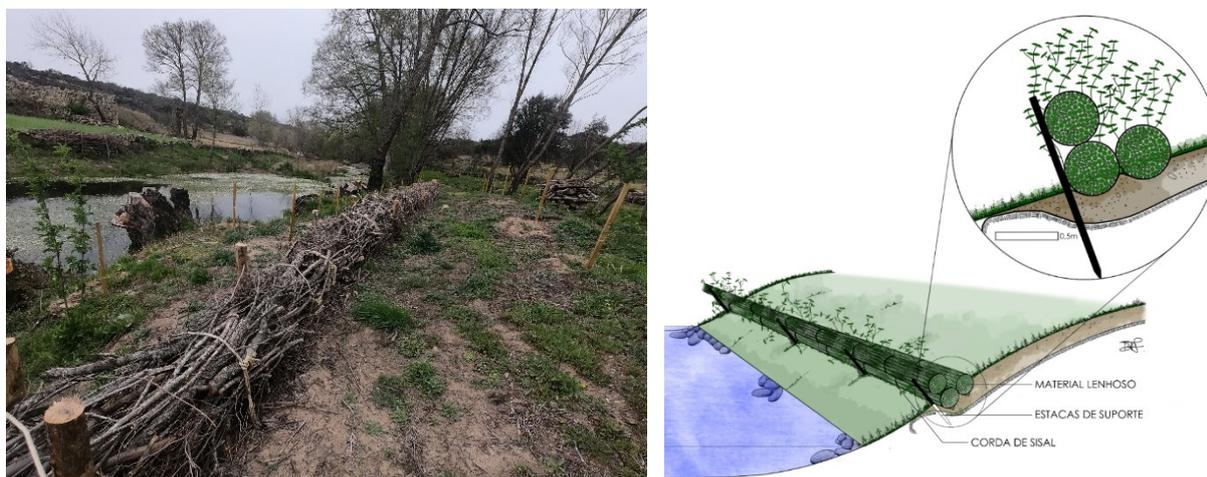
Figura 40 - Faxina viva (secção transversal e alçado)
